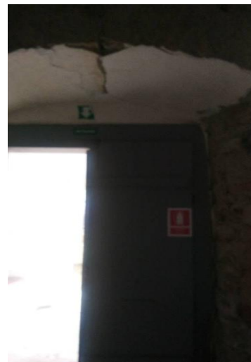
luminat de siguranță pentru marcare cale de evacuare respectiv pentru marcarea extintoarelor substituit cu etichete lipite direct pe perete
