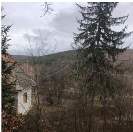
Cablul montat aerian, care alimentează clădirea de pe proprietatea vecină
